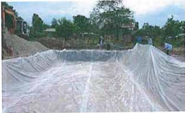
遮水シートの設置 (左)、取水ピットの設置 (右)
