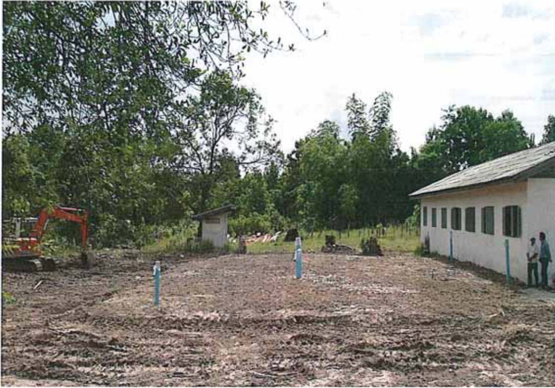
土の埋め戻し
