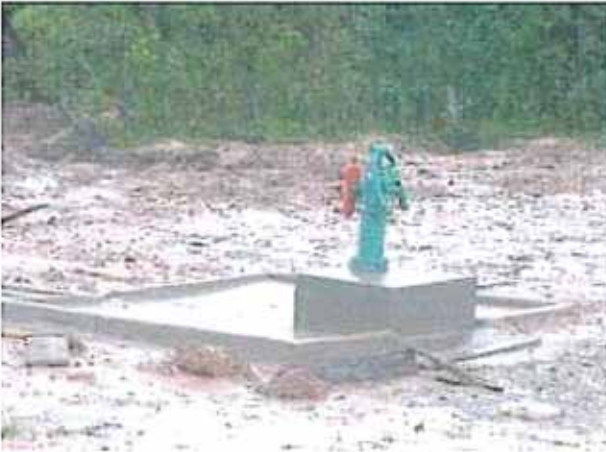
手押し取水ポンプの設置
