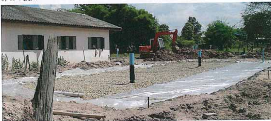
碎石の投入完了、保護シートおよび碎石の埋め戻し
